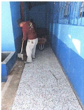
Foto1: Piso instalado en 90%
