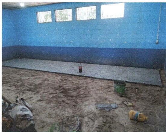
Foto 3: Colocando Piso en 10%
