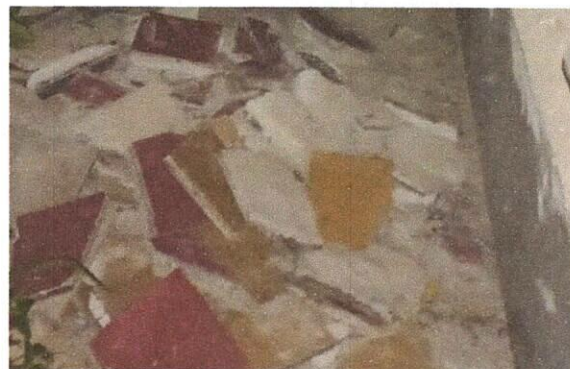
Foto 4: Reparación de entrada
