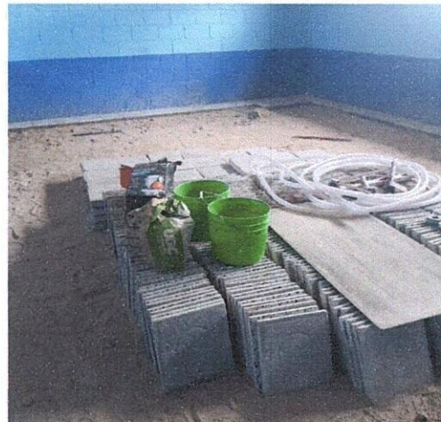
Foto 2: Colocando piso en un 5%
