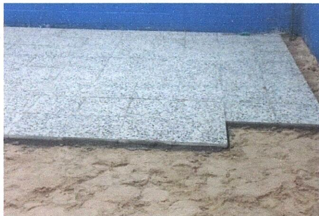
Foto 1: Colocando piso en 20%
