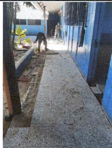
Foto 2: Piso instalado en un 80%
